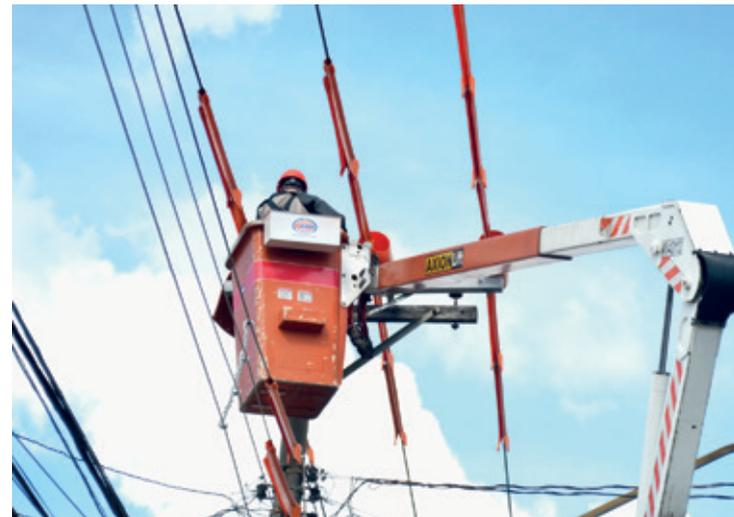
a troca das 65,8 mil luminárias antigas por modernas luminárias em LED e a ampliação do sistema com mais 7,3 mil novos pontos. Totalizando mais de 73 mil luminárias de LED, o que prevê a redução no consumo de energia na ordem de 60%. Isso sem falar, que as lumi-
